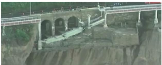
Visão do tabuleiro tombado, ficando claro, apenas observando as fotos, que estava simplesmente apoiado, não havia engaste. A estrutura não se partiu. No trecho haviam três pilares de sustentação da mesa e somente uma viga. Uma onda, cuja força exercida de baixo para cima era muito superior ao peso próprio da mesa, levantou o tabuleiro, pois este estava apenas apoiado.
