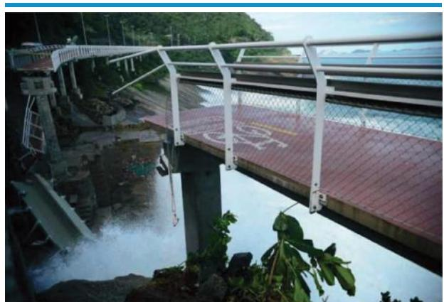
Existe consenso entre os calculistas que: “A ciclovia foi bem construída, mas teve um erro de projeto, que não levou em conta a possibilidade de haver um esforço de baixo para cima, causado por uma onda usual naquele ponto.”
