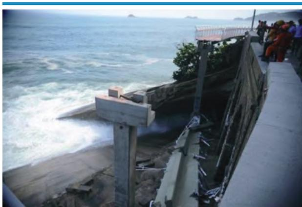
Observa-se que tabuleiro foi apenas encaixado/apoiado, não havia o necessário engaste para combater a força vertical de baixo para cima.
