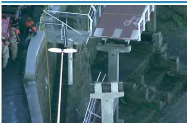
Desgaste prematuro dos materiais usados na construção da ciclovia: corrosão e fissuras nos pilares
